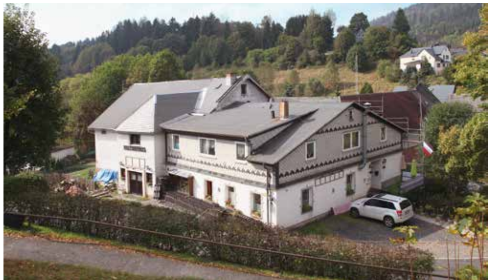
Im Zuge der Ermittlungen gegen das rechte Internetportal Altermedia wurde die Immobilie 2016 von der Polizei durchsucht.
